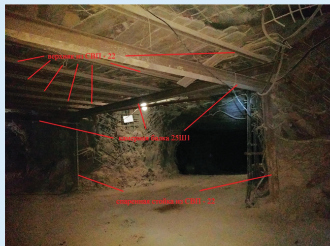
Рис. 2. Крепление сопряжений с помощью камерных рам.
