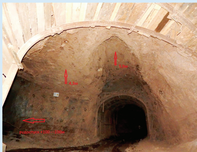
Рис. 1. Сопряжение спирального съезда гор. +100...( \pm 0,0 ) м с рудоспуском на гор. +50 м.
